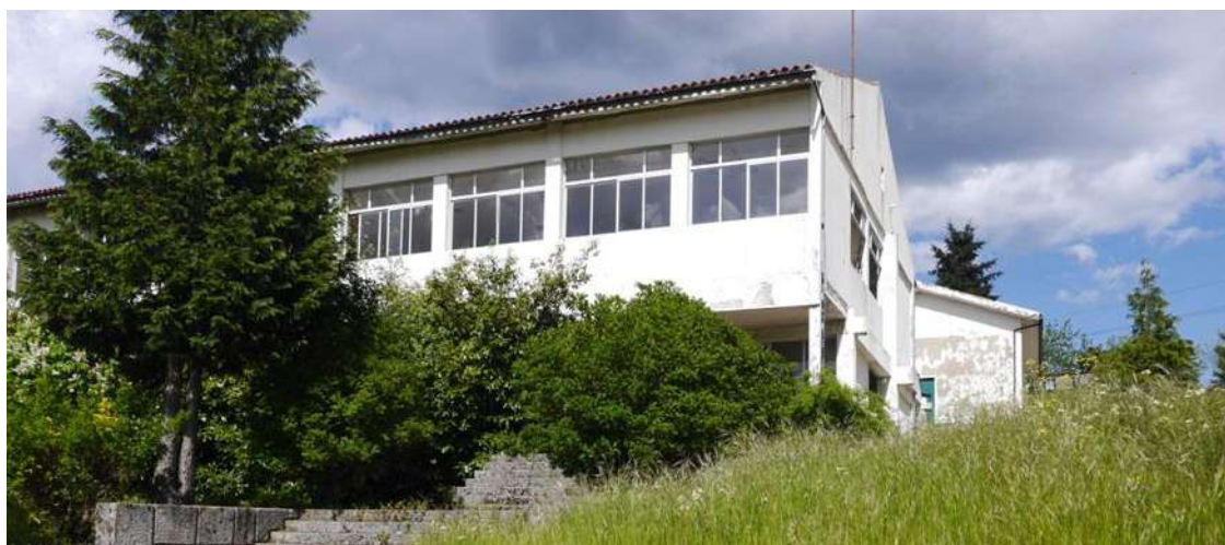
Figura 25 – Edifício em fase final de reabilitação para instalação de Centro de Inovação Social e Cultura | Fonte: CMP
