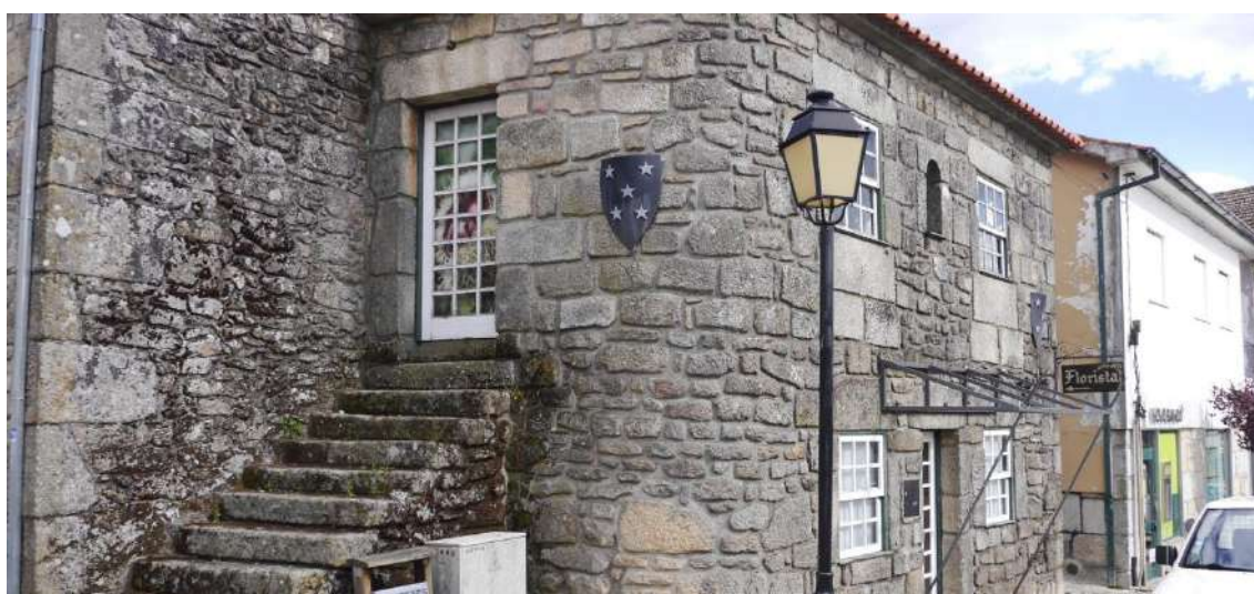
Figura 26 - Edifício reabilitado para instalação de Centro de Mostra e Divulgação | Fonte: CMP
