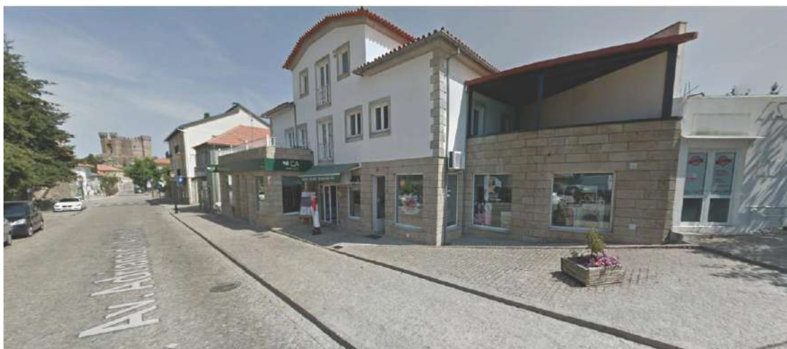
Figura 15 – Centro Urbano de Penedono
