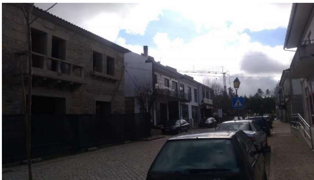
Figura 13 – Centro Urbano de Penedono
